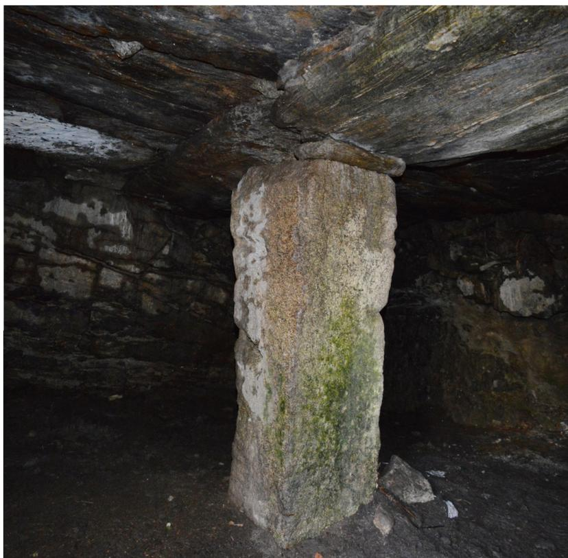
Figura 14: Estrutura e pavimento superior em pedra.
