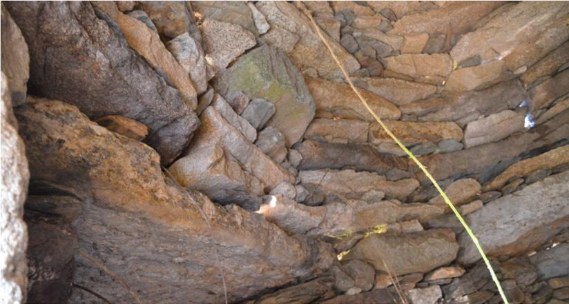
Figura 10: Transição entre a planta quadrada da cardenha e a forma circular da falsa cúpula,
